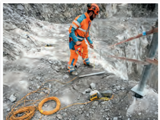
Bohrlochvermessung mit elektronischer Bohrlochsonde Typ Pulsar
