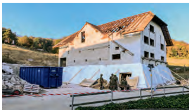
Vorbereitetes Sprengobjekt mit Palisade.
