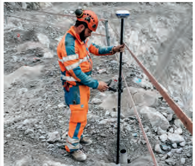
Absteckung oder Aufnahme mit GPS-Stock oder GPS unterstützten Bohrgeräten (Bohrausrichtung).
