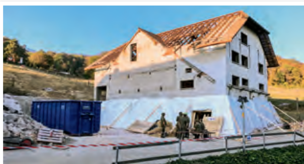
Bâtiment prêt pour la destruction avec palissade de protection.
