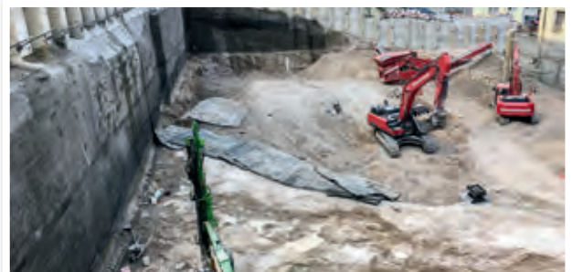
Die geladenen Bohrlöcher sind mit schweren Sprengmatten abgedeckt
