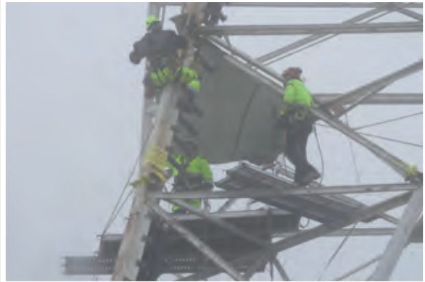
Montage der Schneidladungen
