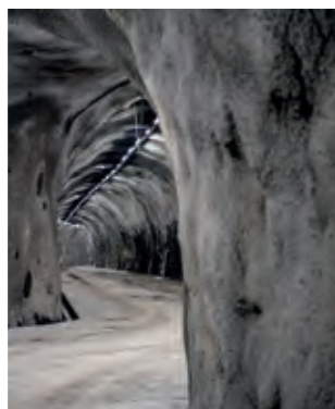
Der fertige Zugangsstollen zur Förderkaverne und zum Fallschacht.
