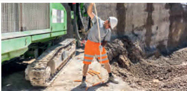
Sprengmeister bei den Ladearbeiten
