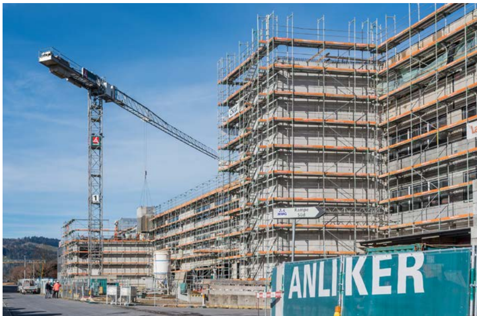
Der Neubau des Backhaus, Stand Februar 2020 zur GV.
