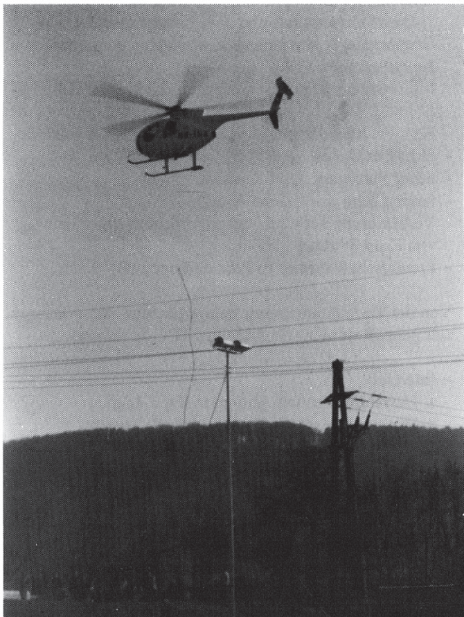
Aufstellen der Lichtmasten per Helikopter
